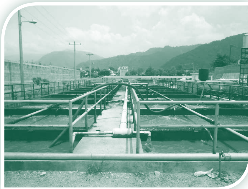
Figura No. 5.12. Tanque de lodos activados de la planta de tratamiento en Panajachel. Fuente: Amigos del Lago de Atitlán, 2017.
